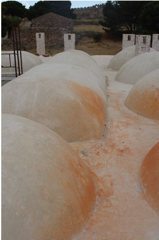
Εικ. 5, 6 Απόψεις του τμήματος μεταξύ των εξωραχίων στοάς και δωματίων στον όροφο (ΝΔ πτέρυγα). Κατά μήκος του τμήματος αυτού θα διαμορφωθεί κτιστός αγωγός μέσω του οποίου τα όμβρια ύδατα θα διοχετεύονται στις τέσσερις ισχυρά προέχουσες λαξευτές υδρορρόες που βρίσκονται κάτω από το γείσο, προς την αυλή του κτηρίου.
